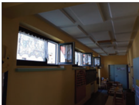
Flur mit neuen Fenstern und Schallschutz
