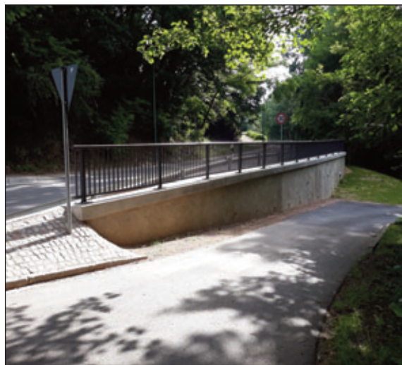
Stützmauer an der Hauptstraße
