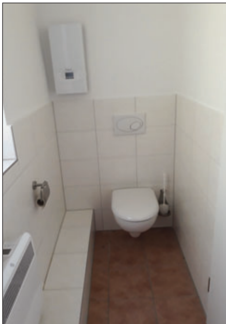
Einbau von neuen Sanitär- und Umkleideräumen im Feuerwehrgerätehaus Ebersbach
