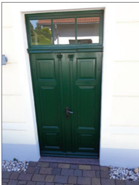
Einbau einer neuen Außentür am Dorfgemeinschaftshaus
