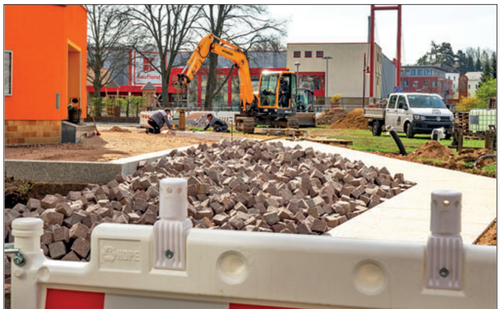
Ganz in Granit: Mitarbeiter der Firma Hoff verlegen Platten und pflastern den Weg zwischen Fronstraße und Kaufland.
