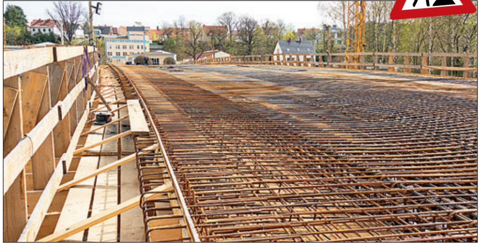
Mitarbeiter der Firma Weißflog flechten momentan die Bewehrung der neuen Brücke am Klinikum.
