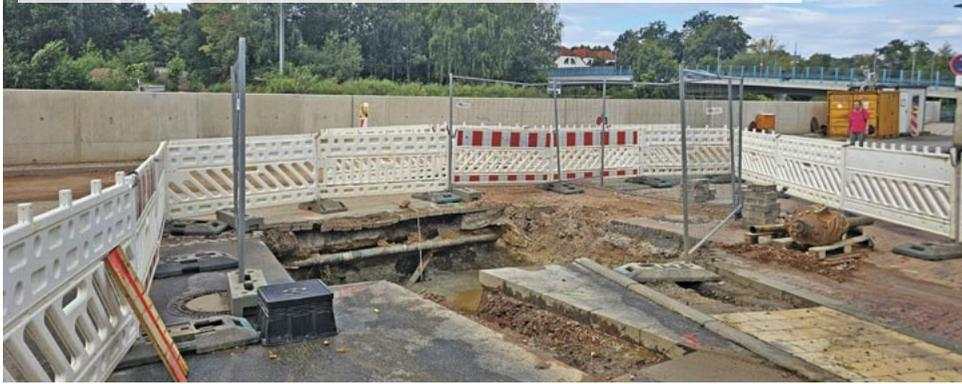
Nur noch wenige Meter Asphalt fehlen, dann ist die Sörmitzer Straße wieder komplett. Doch dort, wo derzeit noch eine Schotterdecke die Straße ziert, hat der Döbeln-Oschatzer Wasserverband eine neue Trinkwasserleitung unter der Mulde verlegen lassen. Dafür war ein aufwendiges Bohrverfahren notwendig.
