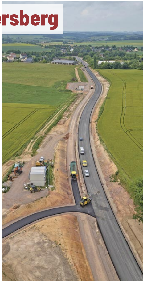
Die Staatsstraße 32 aus Richtung Döbeln kommend mit Blick in Richtung Neudorf. Links neben der Straße beginnt die Asphaltierung des neuen, straßenbegleitenden Radweges. Die Straße an sich ist auf sieben Meter verbreitert worden. Ab September 2025 soll der Verkehr auf dem 1,2 Kilometer langen Abschnitt wieder rollen. Foto: LKW
