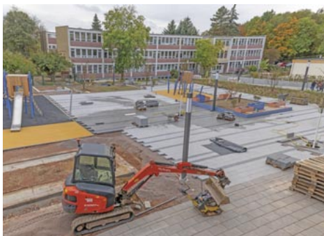
Die Freifläche zwischen alter und neuer Schule soll bis Ende Oktober fertiggestellt sein. Die Außenanlagen des Hortes folgen voraussichtlich im November.
