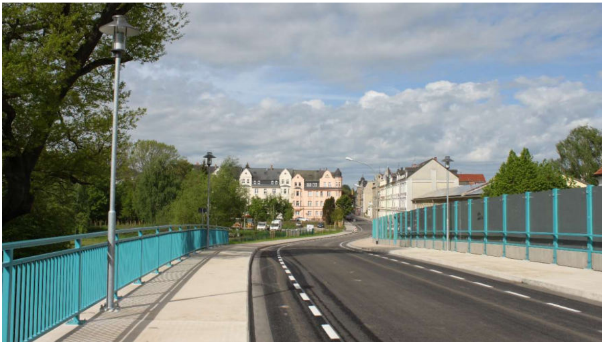
Abbildung 4.1-2: Fertigstellung der 2. Muldenquerung, Blickrichtung Schillerstraße
