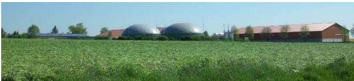
Abbildung 5.1-6: Biomasseanlage im Ortsteil Leschen
