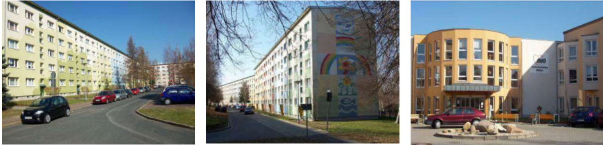
Abbildung 2.8-18: Bebauung Lommatzcher Str., Givorser Str, und AWO Pflegeheim in Unnaer Str.
