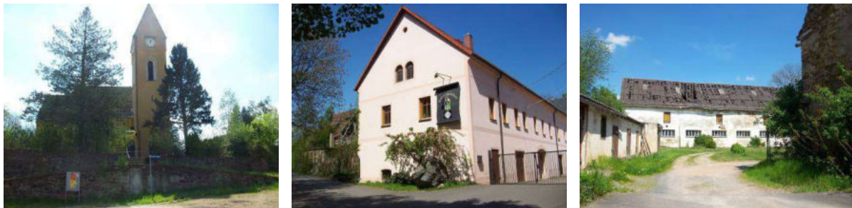
Abbildung 2.8-73: Kirche Simselwitz, ehem. Gaststätte & Pension „Zum Landstreicher“, leerstehende Hofanlage „Zur Feldscheune“ 4/6
