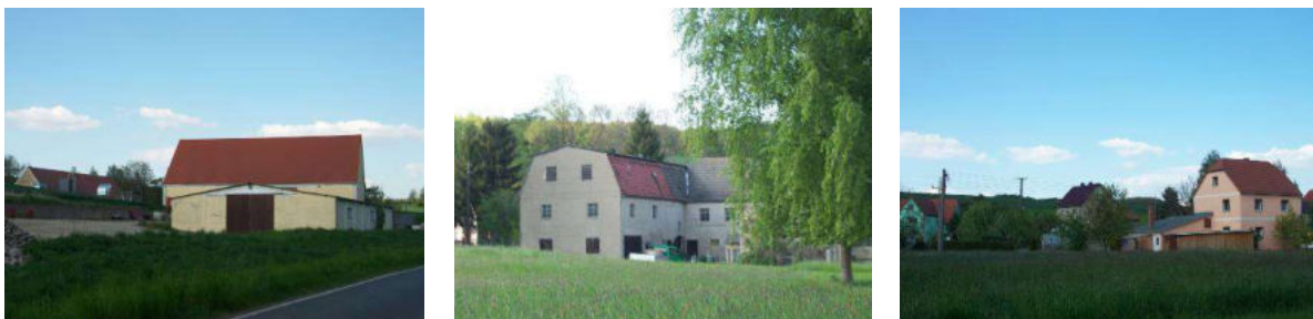
Abbildung 2.8-67: westlicher Ortseingang Nelkanitz, Leerstand in Nelkanitz Nr. 21, Ortsansicht
