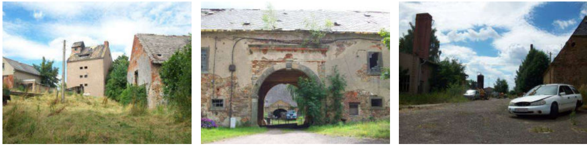
Abbildung 2.8-27: ruinöse Gutsgebäude, Eingang Gutsgebäude, Schrottablagerflächen
