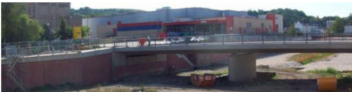
Flutmulde am Busbahnhof
