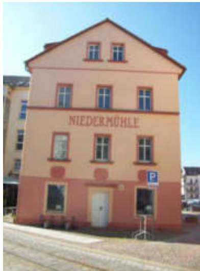
Theaterstraße 5a (Bereich 2)
