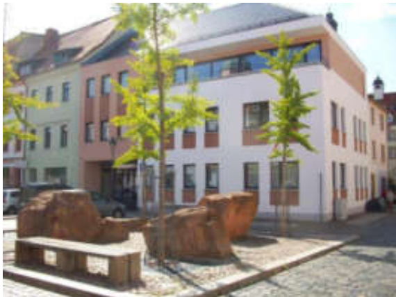
weitgehend sanierte Bausubstanz, teilweise Ersatzneubau
