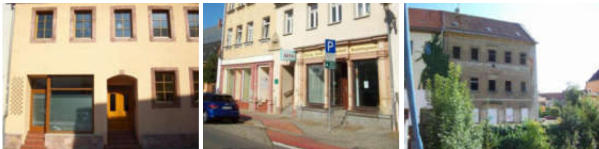
Ritterstraße (alle sechs Objekte)
