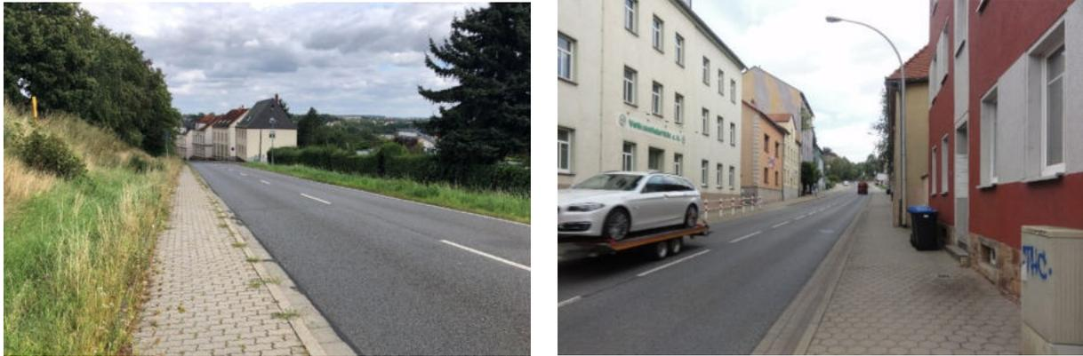
Abbildung 53: Für die Leipziger und Dresdener Straße wird ein einseitiger Schutzstreifen bergauf empfohlen
