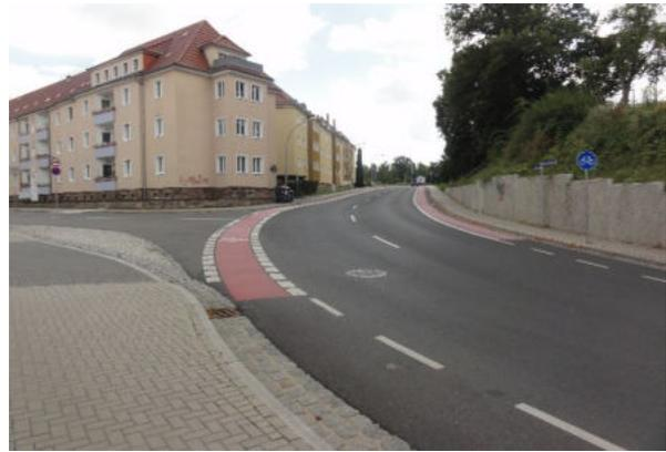
Abbildung 51: Realisierte Radfahrstreifen
