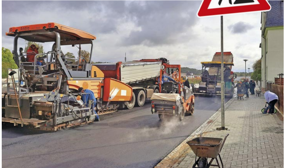
Im September rückte der Asphaltfertiger an der Max-Planck-Straße an. Der Abschnitt zwischen Zuckerfabrik- und Weststraße ist bereits für den Verkehr freigegeben. Auch der Gehweg ist mit erneuert worden. Foto: Uwe Handtrack
