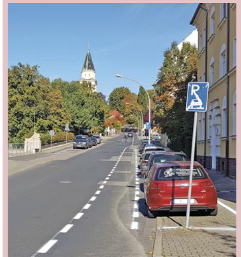
Der Radfahrschutzstreifen an der Rosa-Luxemburg-Straße wurde in Richtung Nordstraße erweitert und die Stellplätze markiert.
