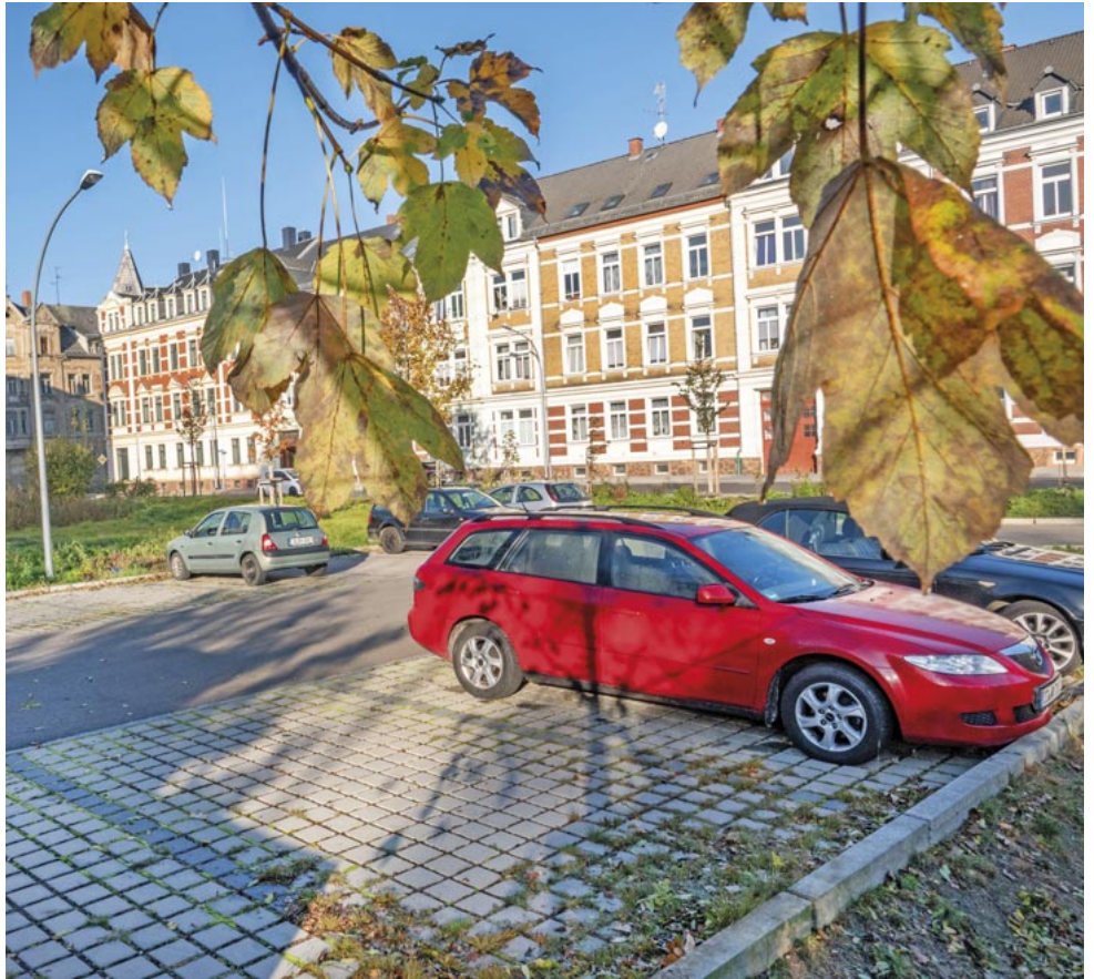
Bis zu 36 Fahrzeuge finden auf dem Parkplatz an der Ecke Schillerstraße/Gabelsberger Straße bisher Platz. Nach der Erweiterung der Stellfläche werden es 22 mehr sein. Seit Ende Oktober wird auf dem Platz gearbeitet. Foto: Lutz Weidler
