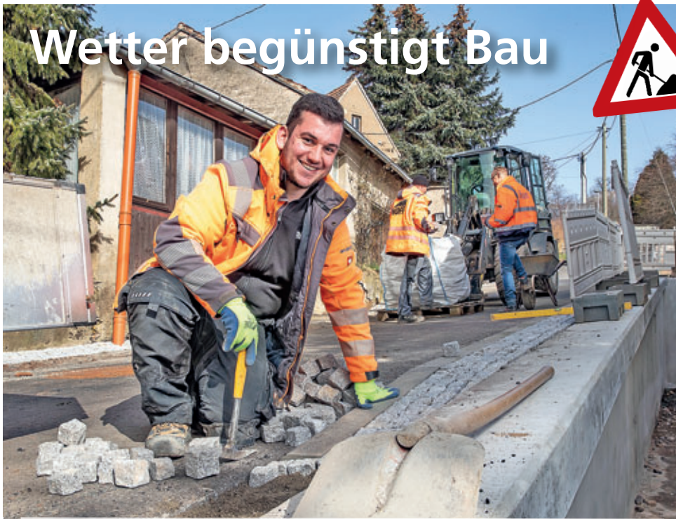
Lukas Honnen von der Ostrauer Firma Hoff Straßen- und Tiefbau hat am Bergring in Schallhausen den Randbereich mit gepflastert. Straße und Stützmauer sind dort erneuert worden. Fotos (2): LKW
